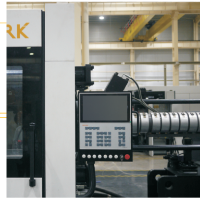
倍福控制系统 BECKHOFF control system
